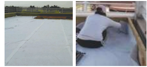
부직포 겹치게 시공 측면으로도 10cm 정도 올라오도록 시공
